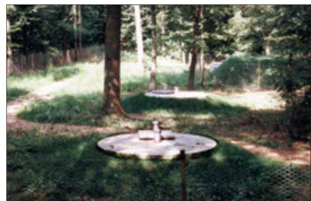
Sickerschlitzgraben und Einzelbohrungen zur Infiltration
