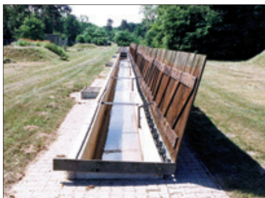
Sickerschlitzgraben und Einzelbohrungen zur Infiltration
