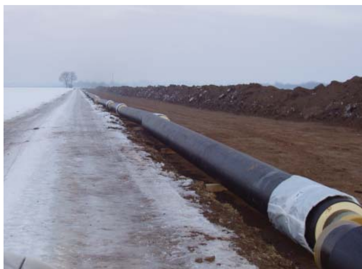
Abbildung 10: Thermalwasserleitungsrohre vor Verlegung
