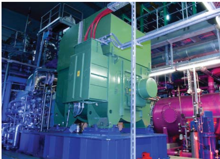
Abbildung 17: Turbine und Ammoniakbehälter der Kalina-Anlage
