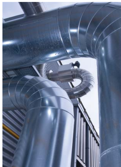
Abbildung 19: Fernwärmenetzanschluss bei der Kalina-Anlage
