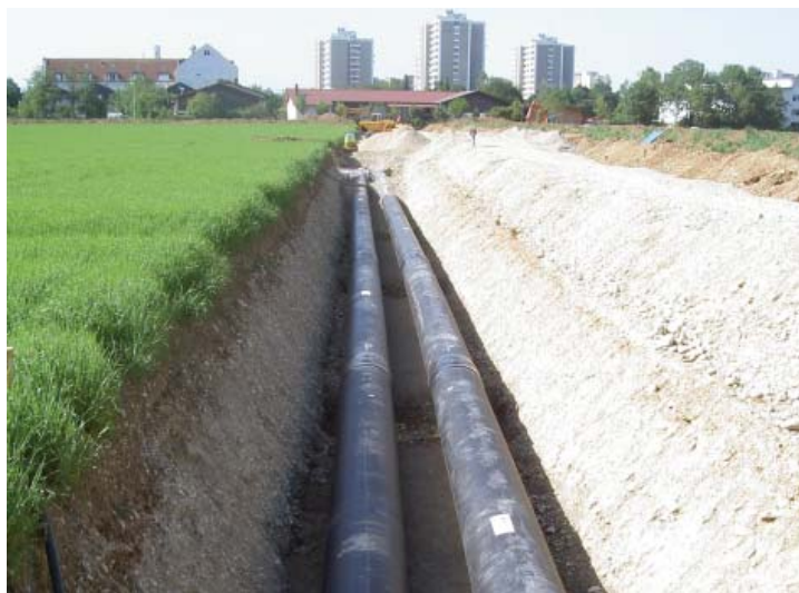
Abbildung 12: Fernwärmenetzbau
