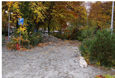
Wasser- und Betonschlamm-massen auf dem Parkplatz, im Hintergrund aufgeschüttete Steine an versiegelter Bohrstelle
