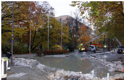
Aufgefangene Wasser- und Betonschlamm-massen nach halberfolgreichem Versiegelungsversuch der Bohrstelle (mit Betonrückfluss)
